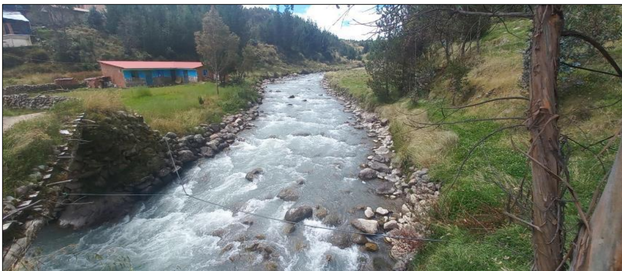
FOTOGRAFIA N°01: TRAMO DE INTERVENCIÓN CON ENROCADO EN LA MARGEN DERECHA DEL RIO PINCHIMURO, EXISTE RIESGO DE POSIBLE INUNDACIÓN Y CAUCE COLMATADO.
